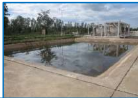
รางระบายน้ำและบ่อคอนกรีตเก็บน้ำ (Concrete Pit)
